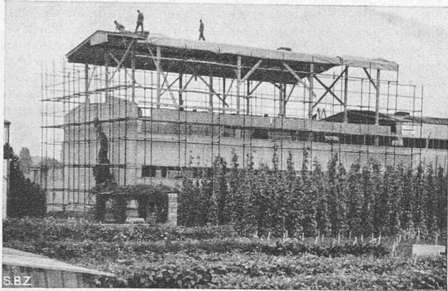
Abb. 6. Die eine Hälfte des Daches ist gehoben
