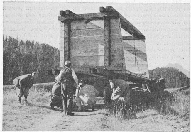
Abb. 6. Transport des hölzernen Durchfluss-Kastens
