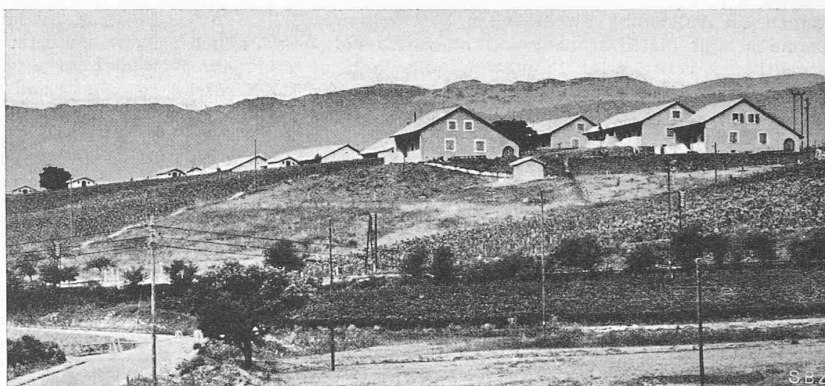
Abb. 20. Wohnkolonie, westlich des Kraftwerkes (vergl. Abb. 17)
