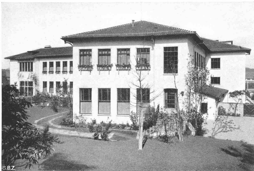
Abb. 2. Gesamtbild aus Südost
