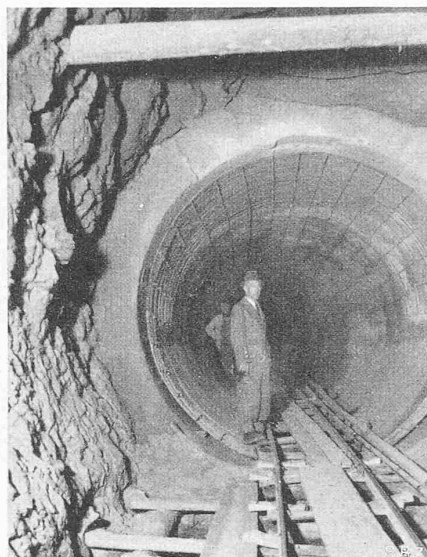
Abb. 13. Druckstollenprofil mit armerter Gunitauskleidung
