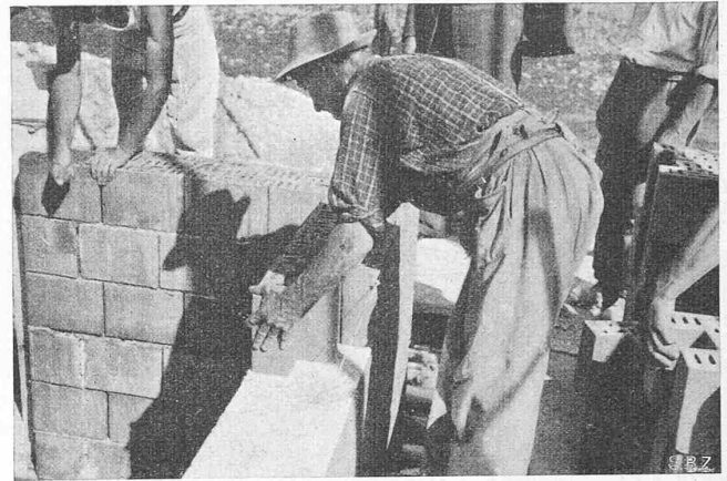
Abb. 1. Versetzen der Novadom-Ziegel auf Perfekta-Platten
