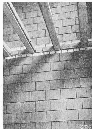
Abb. 4. Novadom-Trockenmauer
