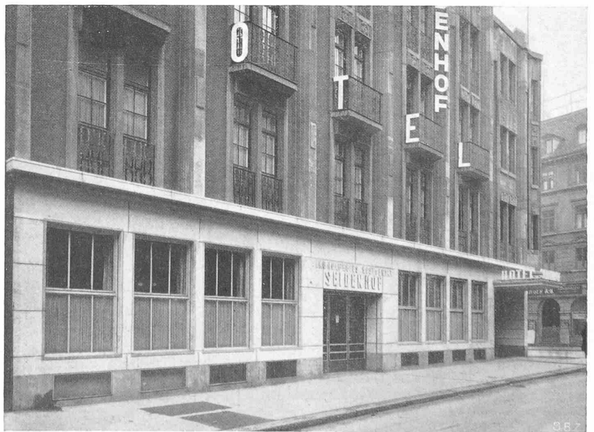
Abb. 1. Hotel Seidenhof: Mitte Eingang zum Restaurant, hinten Hoteleingang
