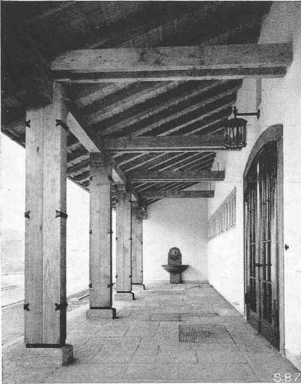
Abb. 3. Vorhalle in Eiche mit Eisenbeschlägen
