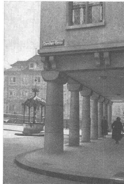
Hotel Storchen, Zürich Säulen in Plastimentbeton mit Kunststeinummantelung
