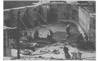
Elektr.-Werk Freiburg Abdichtung des Einlaufkanals
