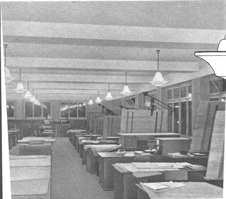
Indirekte Bürobeleuchtung mittels Mischlichtlampen
