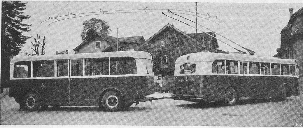
Abb. 1. Trolleybus samt Omnibus-Anhänger mit Vierradlenkung A.-G. Adolph Saurer, Arbon
