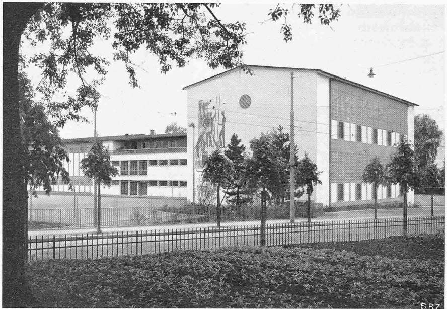
Abb. 3. Ansicht aus Norden, von der Gloriastrasse aus
