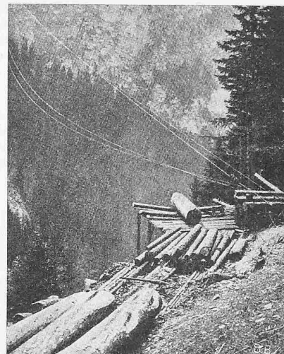
Abb. 3. Drahtseilriese (Graubünden)
