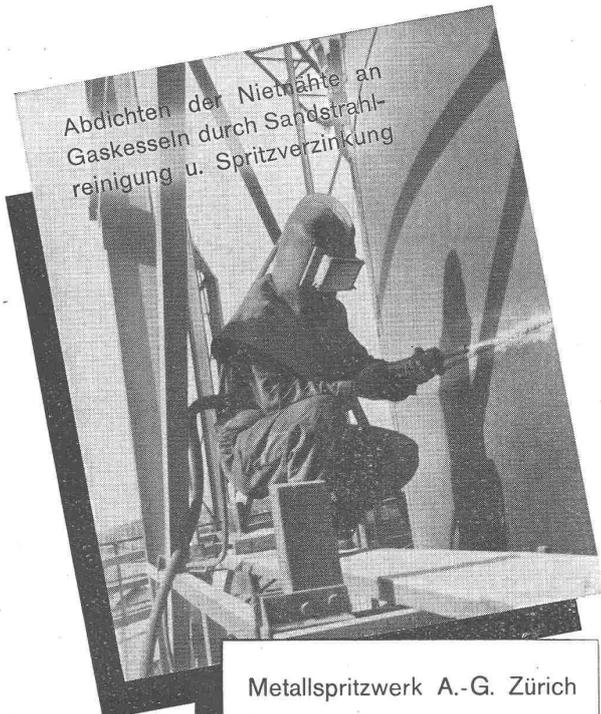
Abdichten der Nietnähte an Gaskesseln durch Sandstrahlreinigung u. Spritzverzinkung
