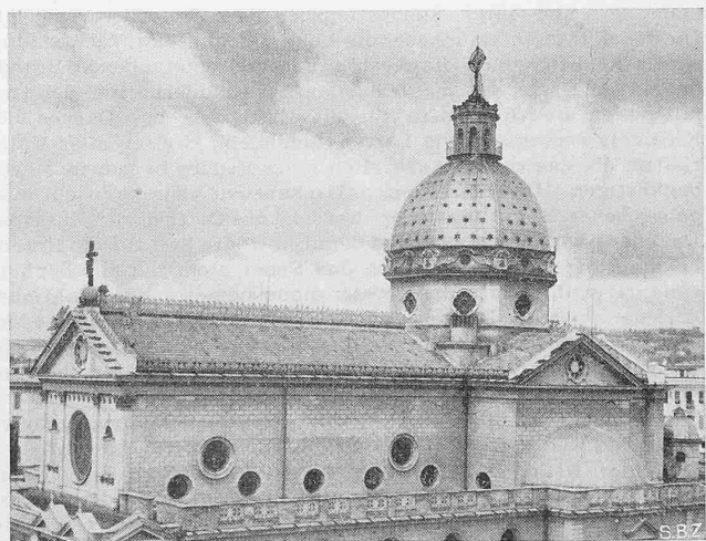
Abb. 5. San Gioacchino in Rom, Architekt Lorenzo Maria De Rossi, Kuppeln 1897 mit schweizerischem Reinaluminium eingedeckt
