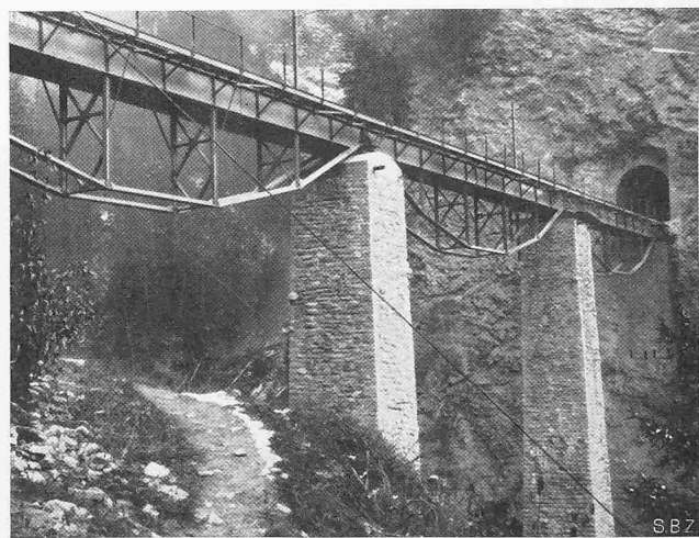
Abb. 20. Der umgebaute Viadukt mit drei einfachen Blechbalken
