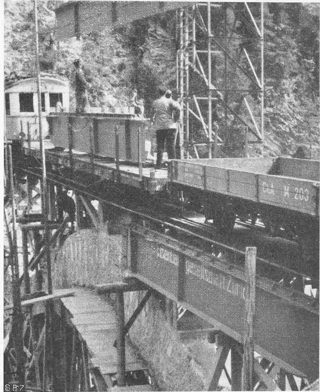
Abb. 39. Einbau der Versteifungsträger in je drei Stücken
