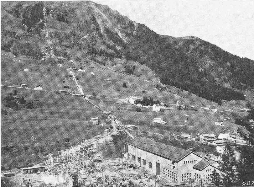
Abb. 12. Gesamtbild aus Südwesten
