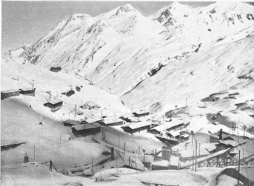
Abb. 5. Der Installationsplatz aus Südwesten, am 14. Dez. 1943
