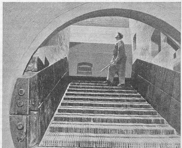
Abb. 7. Der Anzünd-Rost (5 in Abb. 3)
