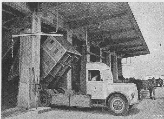
Abb. 4. Entleerung eines Ochsner-Kehrichtsammelwagens in den Tiefbunker
