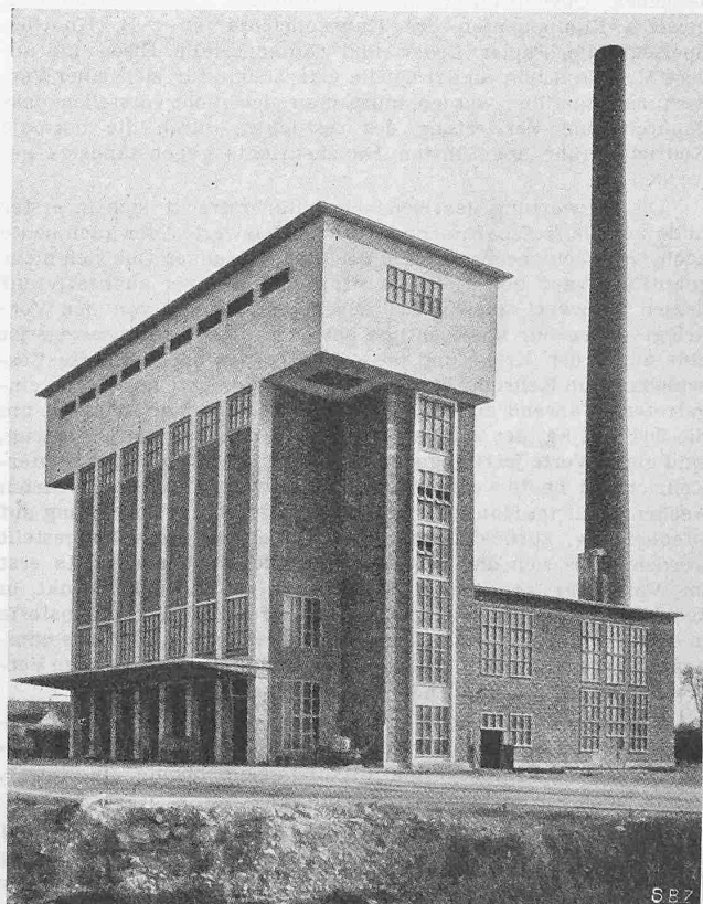
Abb. 2. Ansicht der Verbrennungs-Anlage (Seite Wärmestation)
