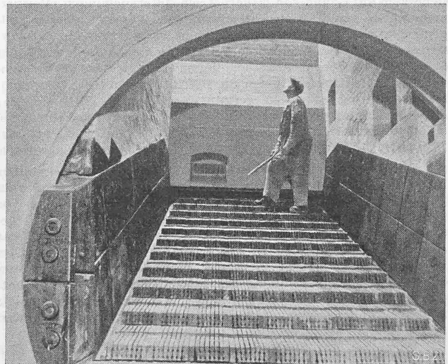
Abb. 7. Der Anzünd-Rost (5 in Abb. 3)
