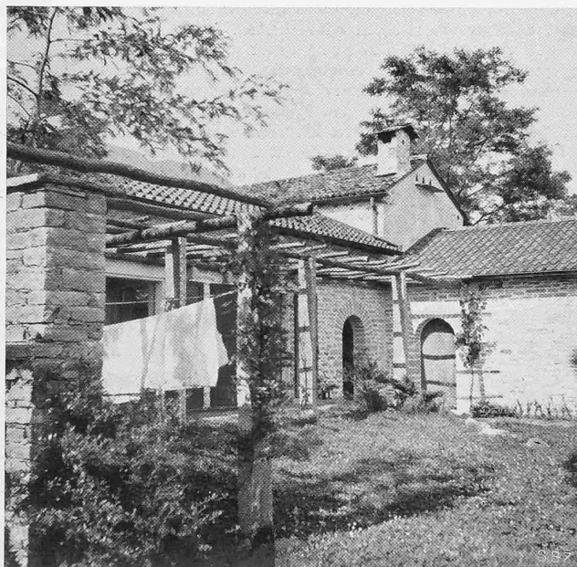
Abb. 6. Die Wohnterrasse gegen Nordost
