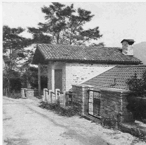
Abb. 3. Als Garage umgebauter Ziegenstall; Eingang
