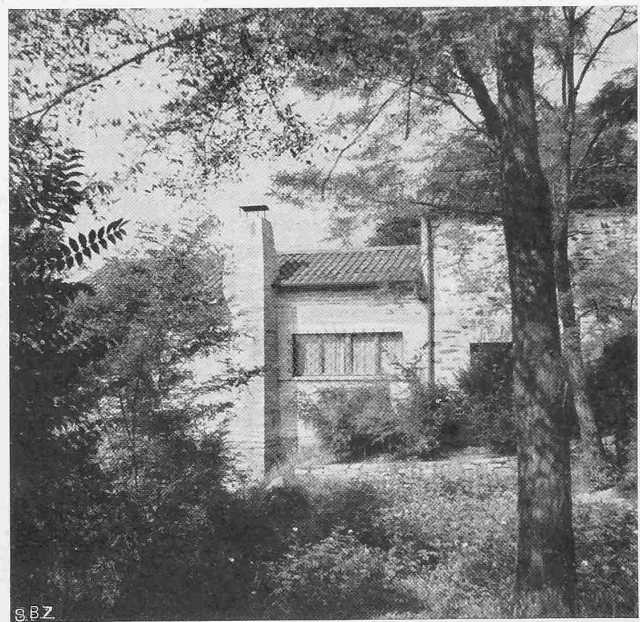
Abb. 8. Mittlerer Teil der Ostfront (Essnische-Fenster)
