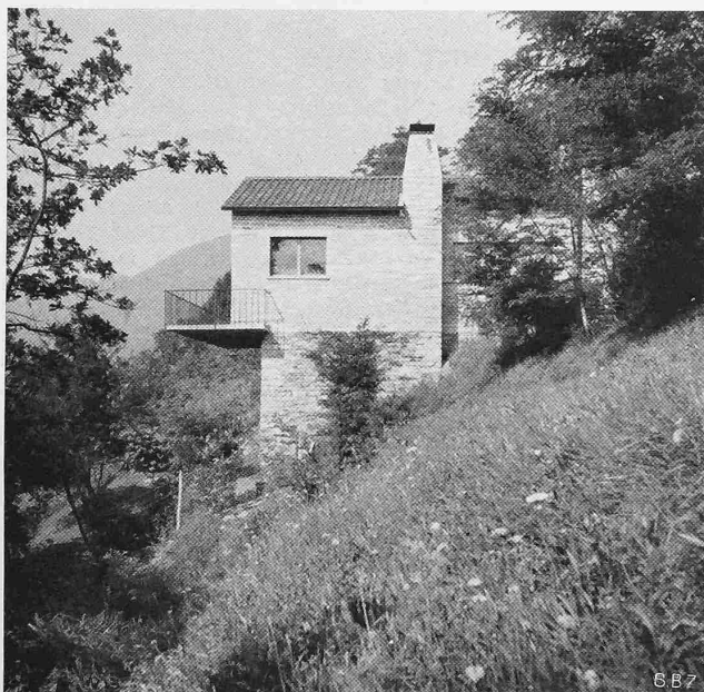
Abb. 8. Seeseitiger Teil der Ostfront (Wohnzimmer-Fenster)
