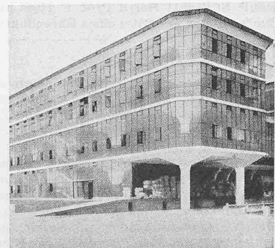
Abb. 5 bis 8. Die geschichtete Wand verleiht dem Bau den Ausdruck eines bis in die äussersten Nerven durchpulsten Organismus — ein Charakter, der durch alle Zeiten und Materialien konstant bleibt
