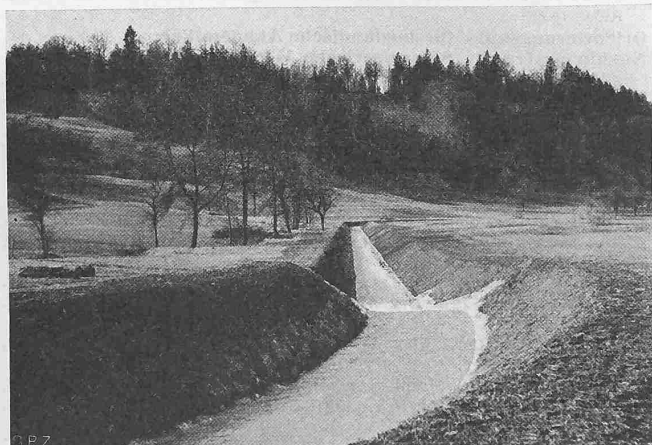
Abb. 3. Alte Schule, Gegenbeispiel: in Grundriss und Längenprofil schematische, rücksichtslose Trassierung einer Bachkorrektur
