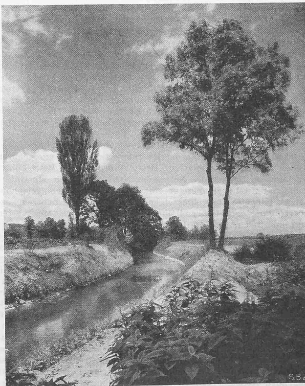
Abb. 4. Durch leichte Schmiegun g des Laufes und Schonung der Vegetation fügt sich auch ein korrigierter Bachlauf ins Landschaftsbild
