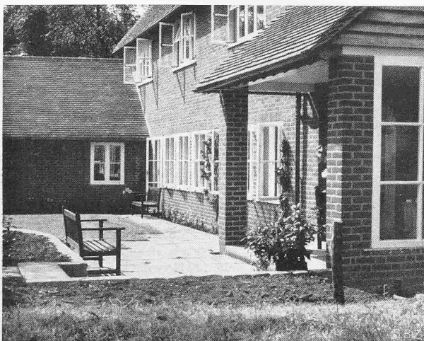
Abb. 8. Loggia und Südfassade im Gartenhof Bodenbelag aus grauen Sandsteinplatten
