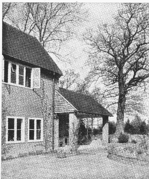
Abb. 10. Loggia mit verglastem Sitzplatz unter alten Eichen, im Winter
