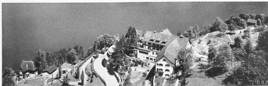
Tiefblick aus Süden
