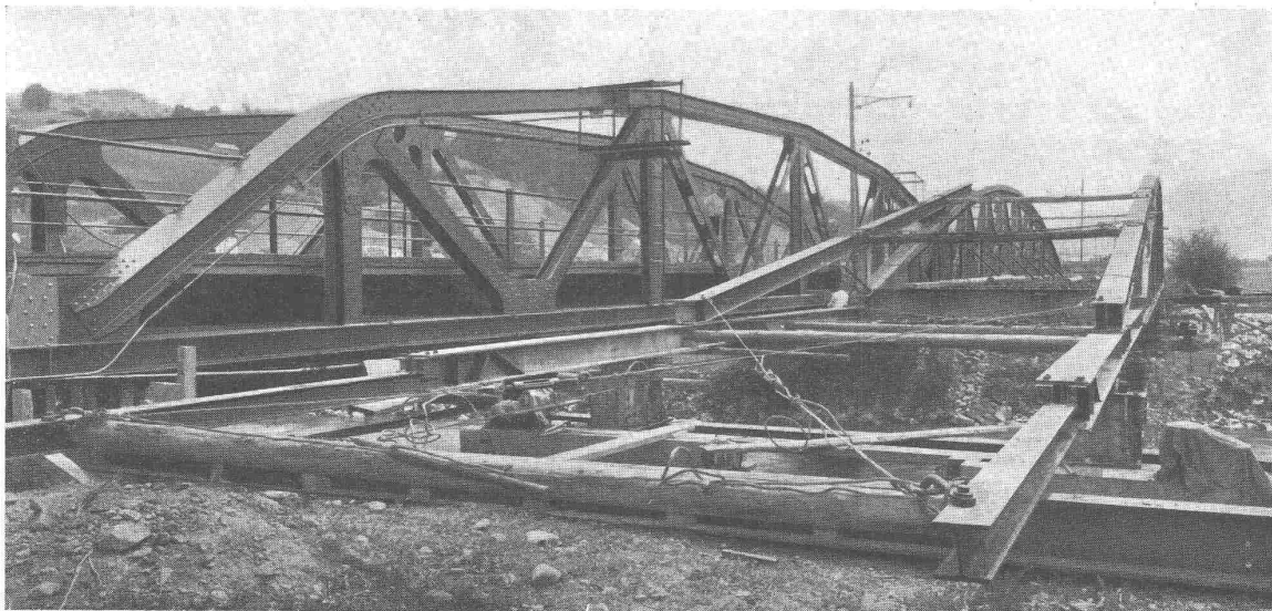
Thurbrücke Ullsbach SBB-Strecke Wattwil-Nesslau
