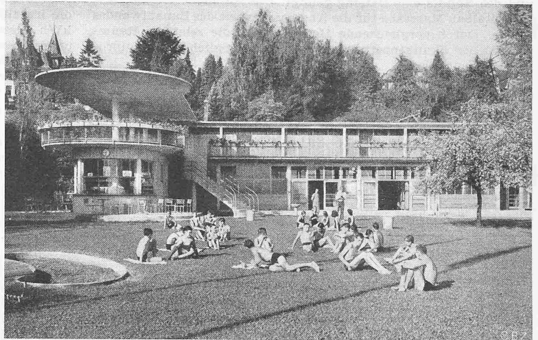
Abb. 6. Südliche Hälfte des Baues, mit Kiosk
