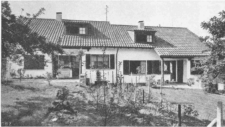
Abb. 7. Südseite Doppelhaus A
