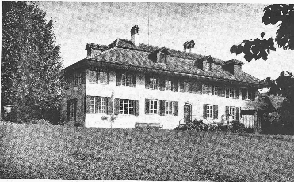
Abb. 1. Der umgebaute Landsitz «Mannenberg» in Ittigen bei Bern, aus Südwesten
