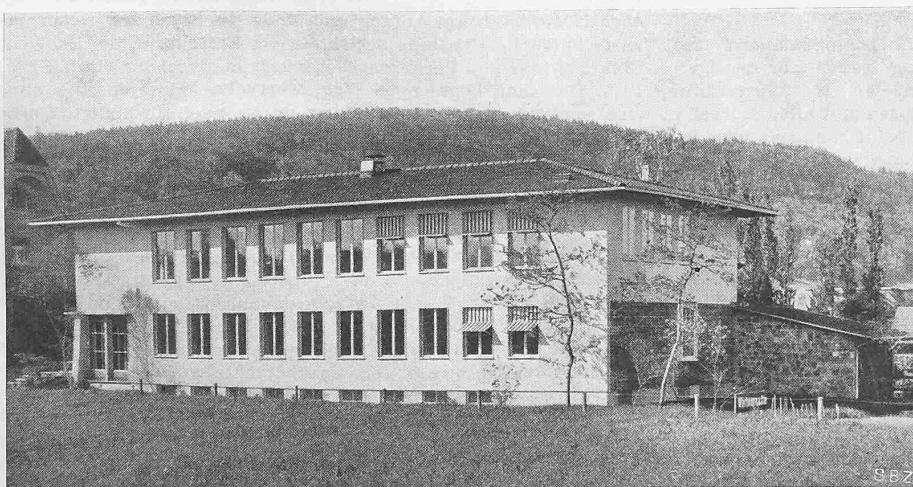
Abb. 1. Bureaugebäude Wartmann & Cie., Brugg. Arch. Walter Hunziker, Brugg. — Südostfront
