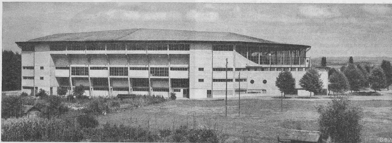
Abb. 1. Ansicht der westlichen Längsseite; rechts einer der beiden halbhohen Haupttreppenhaus-Flügel. Phot. Wolgensinger
