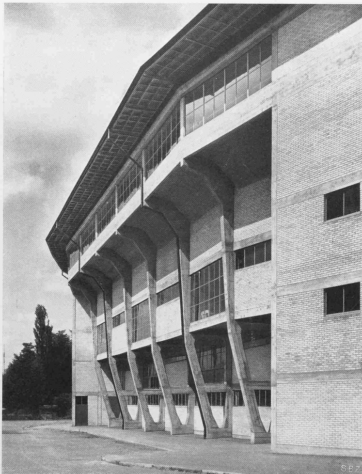
Oestliche Langseite, eingefasst durch Nottreppenhäuser
