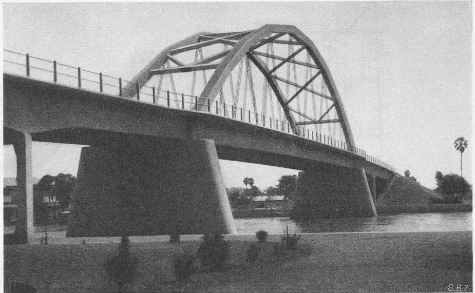
Bild 1. Die Brücke aus Südwest (Ayuthiasseite), von unterstrom her gesehen
