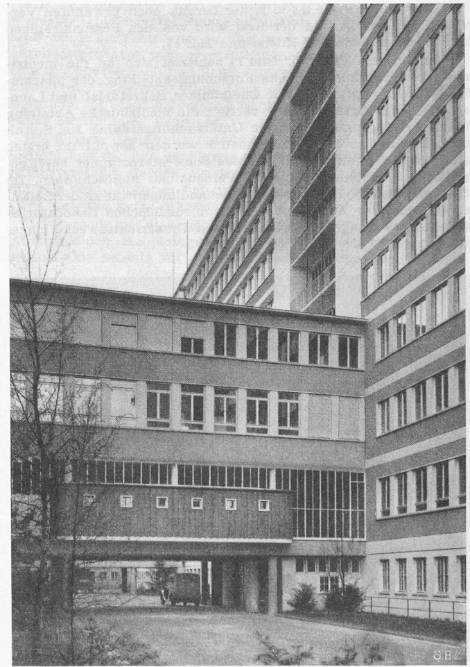
Bild 12. Hof u. Zwischenbau 3, Vorfahrt Krankenannahme im 1. U.-Geschoss
