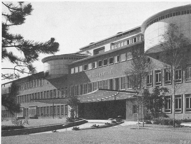
Bild 5. Haupteingang an der Spitalstrasse
