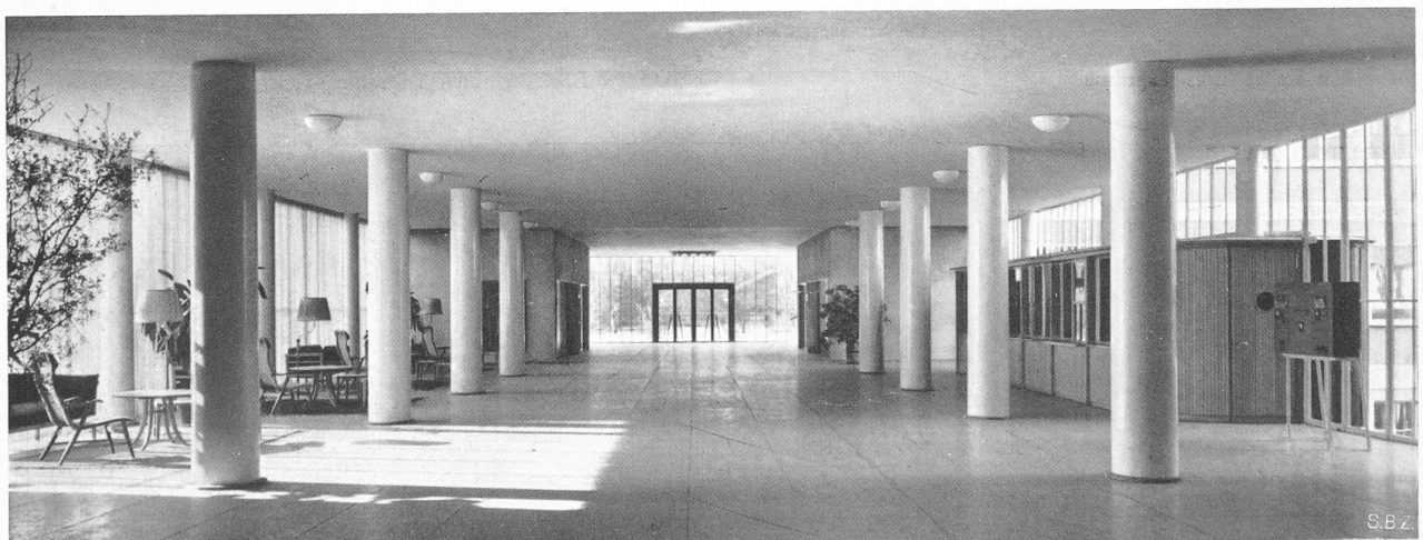
Eingangshalle im Erdgeschoss mit Durchblick zum Garten, rechts Kiosk und Post, links Sitzgelegenheiten
