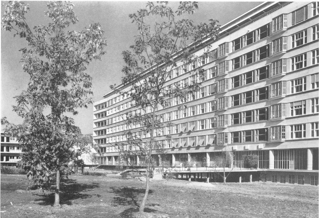
Südwestfassade des Bettenhauses mit Erdgeschoss-terrasse und Garten; links Infektions-Krankenhaus
