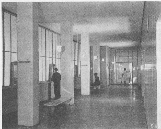
Bild 11. Verwaltung, Schalterhalle im Erdgeschoss
