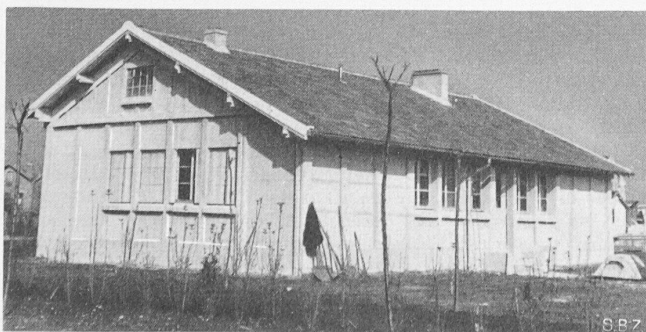
Bild 4. Maison «Jeep», Eisenbetonelemente
