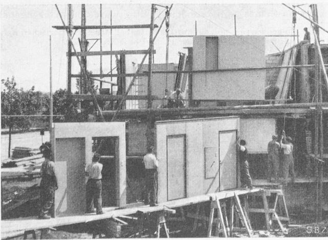
Bild 6. Antransport und Heben der Elemente aufs Obergeschoss
