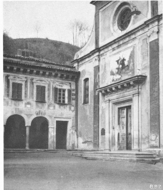
Arkaden und Südwestfassade von San Giorgio
