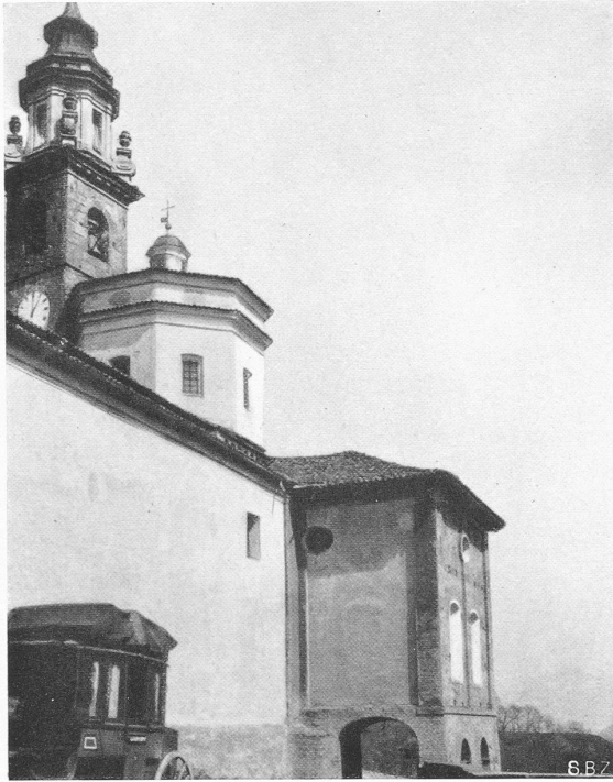
San Giorgio, Südostseite
