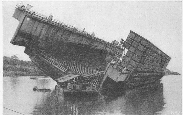
Bild 5. Das Dock wird in Hochkant-Stellung gebracht
