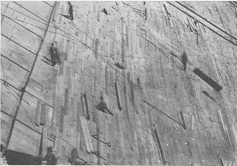
Bild 6. Verlegen der «Wakefield»-Bohlen in fertigen Einheiten mit 10 cm Längsfugen und 1 cm Querfugen
