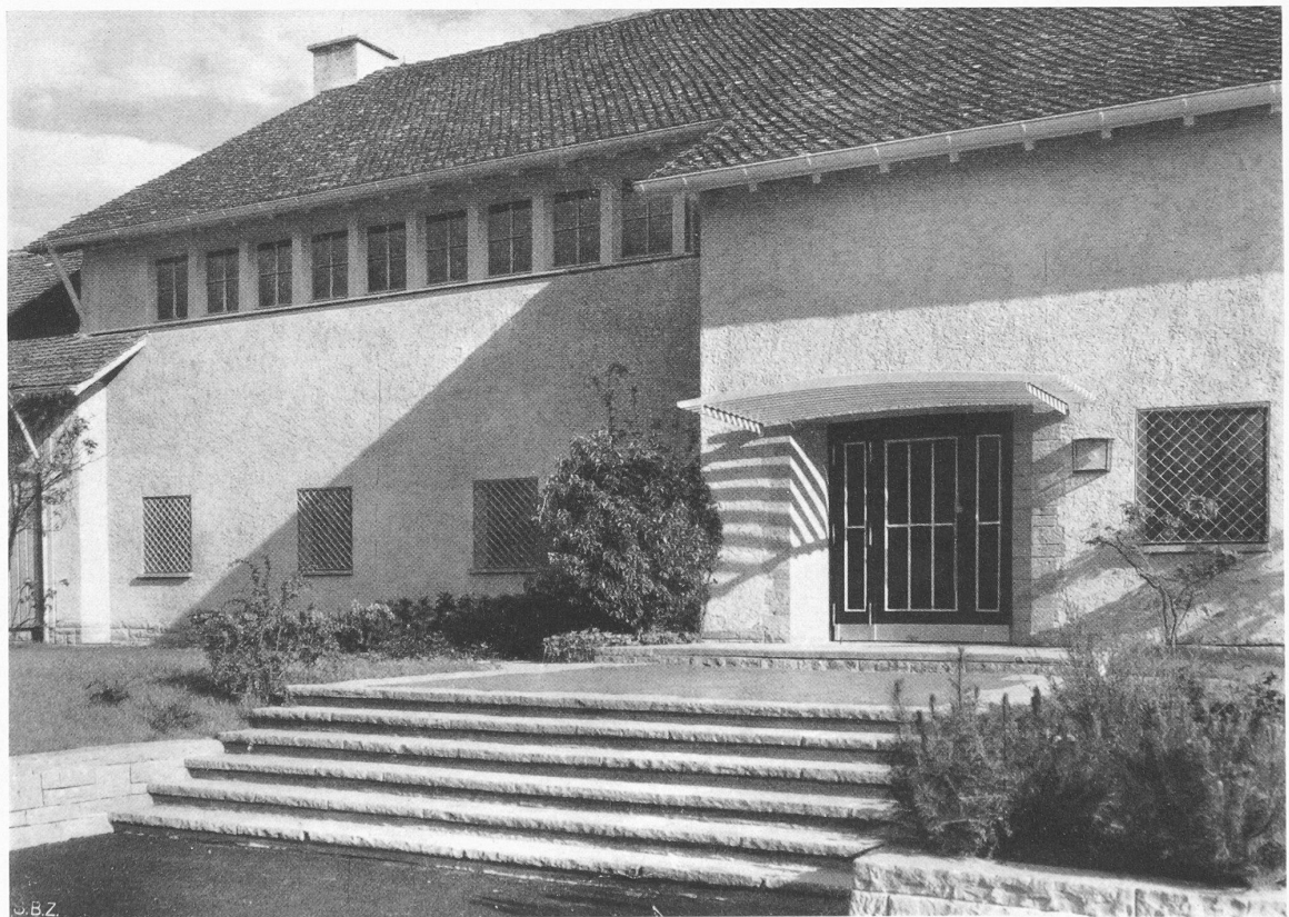
Schulhäuschen auf der Egg in Zürich-Wollishofen, Nordseite
