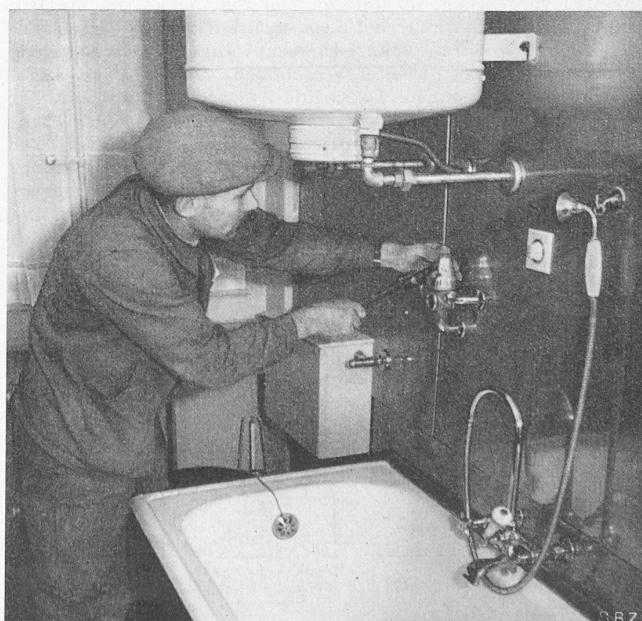
Bild 4. Montage der Armaturen
