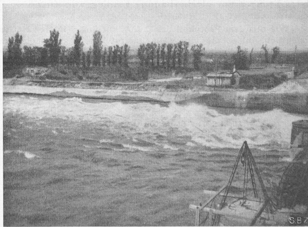
Bild 18. Abflussbild bei 500 m 3 /s durch Oeffnung 5; rasche Beruhigung des Abflusses; Entwicklung starker Querdüngung. 16. Mai 1946
