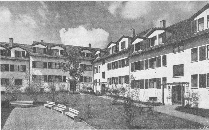
Bild 5. Ueberbauung Laubegg aus Osten, vorn Kinderspielplatz
