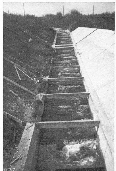
Bild 31. Strömung im Fischpass
