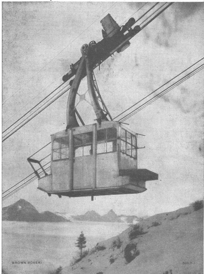
Die Schwebbahn Beckenried-Klewenalp ist mit einem Gleichstrommotor von 82 kW ausgerüstet
