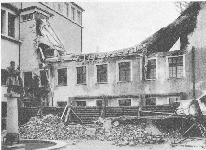
Bild 7. Museum zu Allerheiligen, Schaffhausen Zerstörungen im Westtrakt
