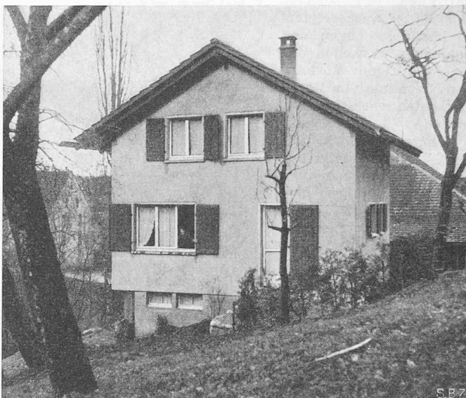
Bild 3. Vierzimmer-Arbeiterhaus im Kienberg (Solothurn)
