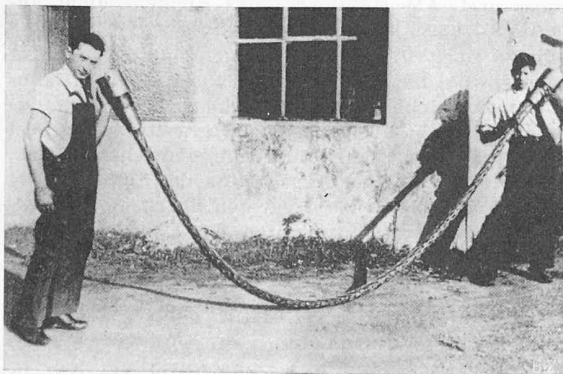
Bild 4. Vorgespanntes Kabel aus Drahtgeflecht nach Chalos
