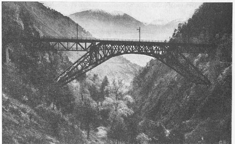
Bild 6. Der Bietschtal-Viadukt der Lötschbergbahn, 1911/1913. Spannweite 95 m
