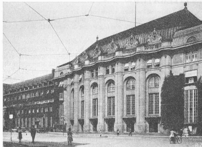
Bild 14. St. Gallen, 1912. Der Bahnhof als Barockpalast, in der Absicht einer Anpassung an örtliche Baudenkmal. Die festlich-höfische Tonart der Aufgabe nicht angemessen, trotz nicht unbegabter Formulierung
