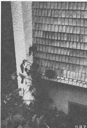
Bild 24. Anschluss der Schindelwand an die Mauer
